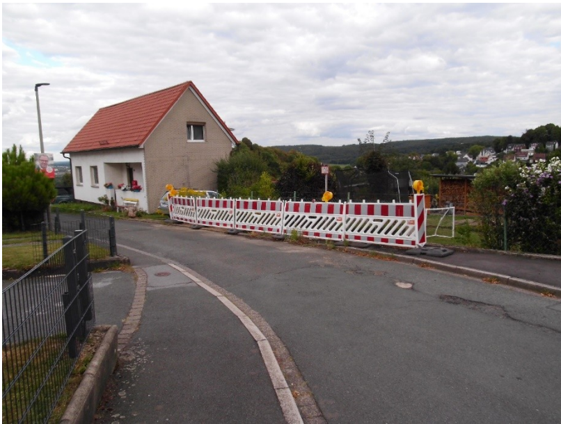
Schillerstraße 44, seit 2024 Baustelle
